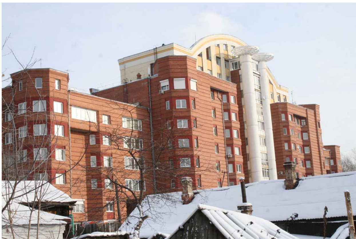
Рис. 29. Дом с «коронай», расположенный на ул. Красноказачьей
