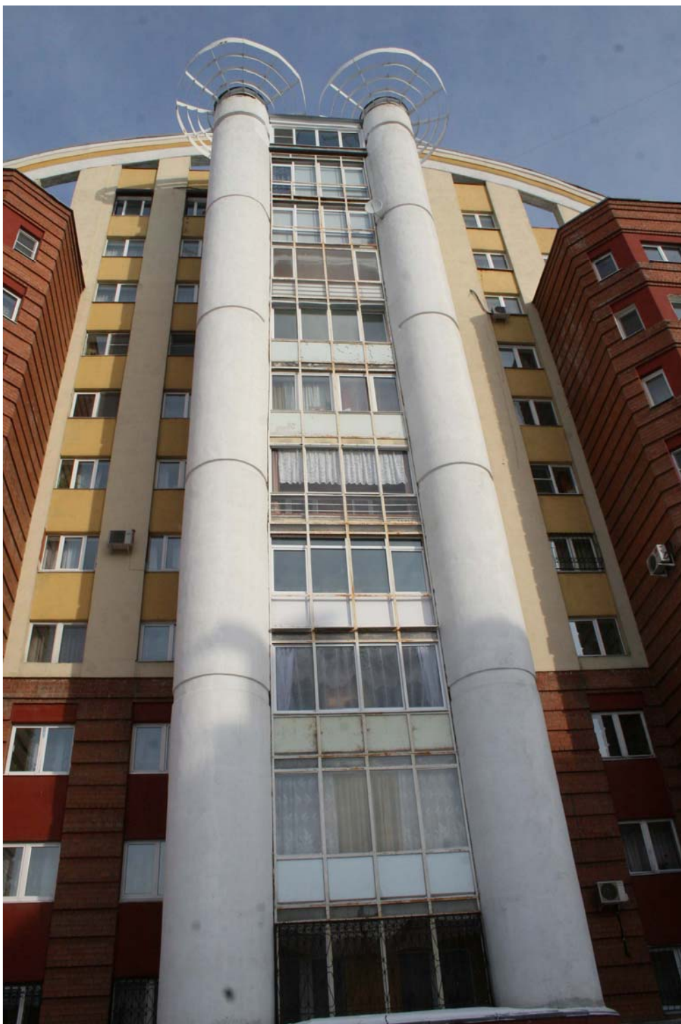
Рис. 30. Ризолит в центре дома с «короной», выполненный с применением труб диаметром «тысячка»
